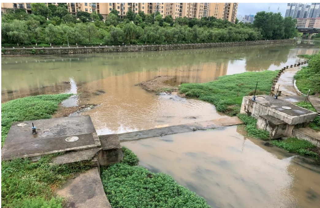
图 2.1-1 潭口溪汇入口河道现状
