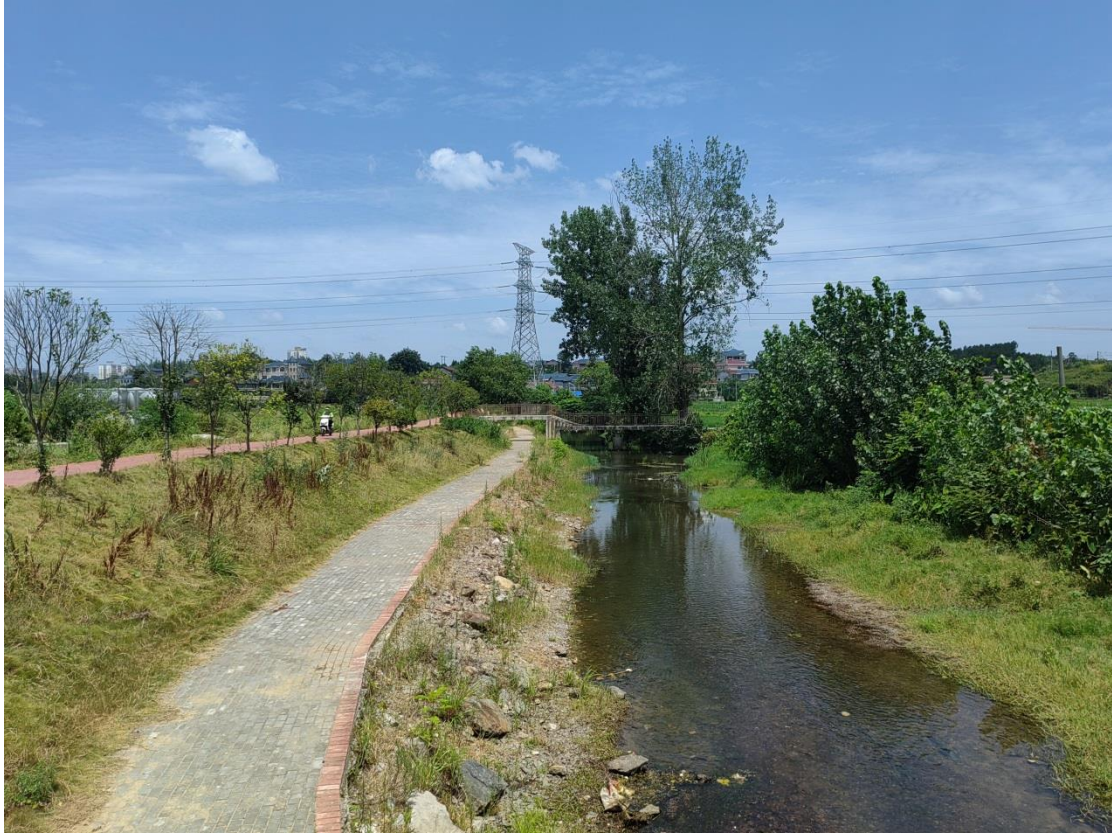
图 1.1-5 坨院溪鹤城区河段河道现状图二
