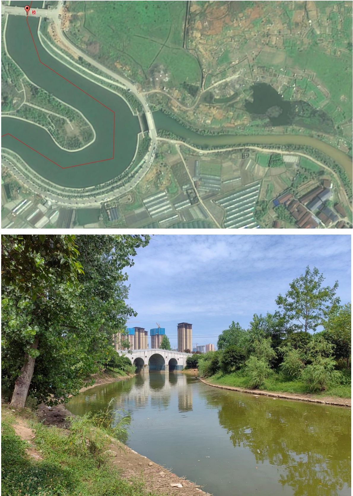
图 1.1-2 坨院溪鹤城区河段河口现状图
