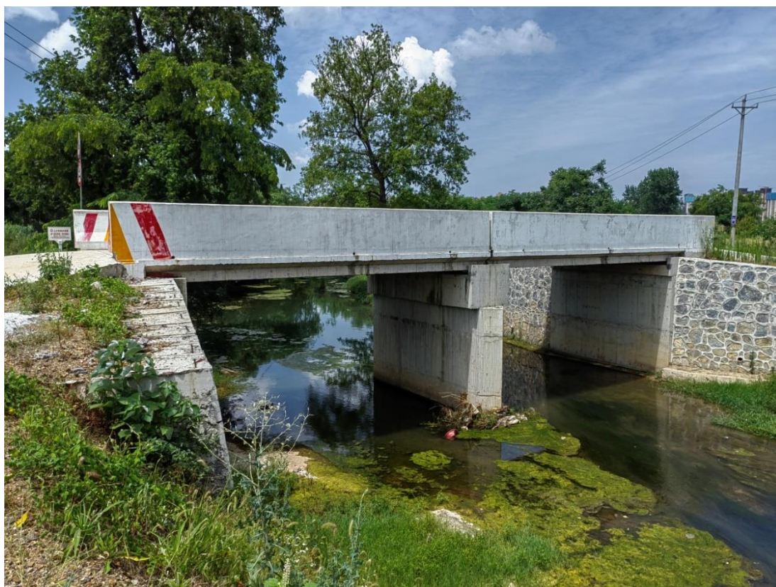
图 1.1-10 坨院溪鹤城区河段桥梁现状图
